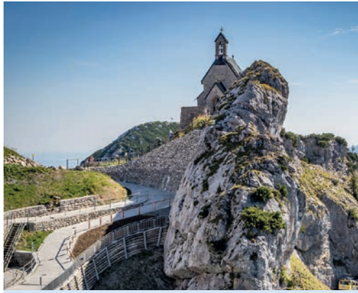
Wendelstein Seilbahn www.wendelsteinbahn.de © Archiv der Wendelsteinbahn GmbH
