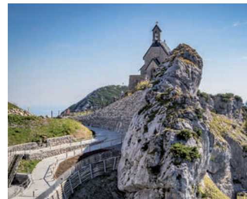
Wendelstein Seilbahn www.wendelsteinbahn.de © Archiv der Wendelsteinbahn GmbH
